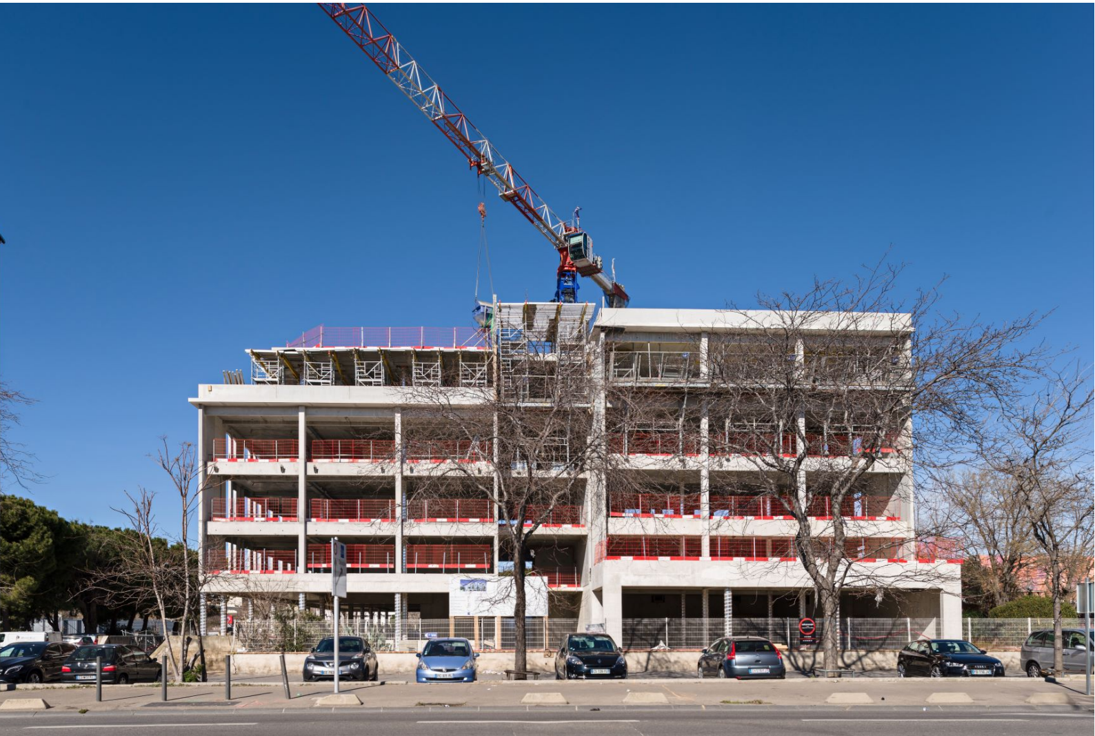
En couverture, perspective de l'Olivier © Agence d'architecture Gérard Manavella et sur cette page, photo du chantier de l'Olivier démarré en avril 2018 pour une livraison en septembre 2019 © Yann Bouvier
