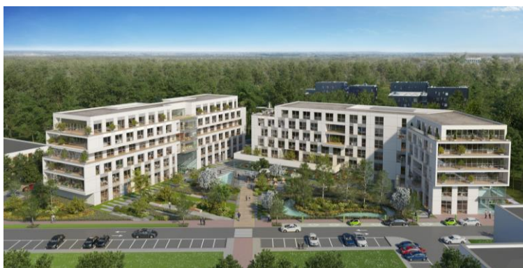
Parc Eiffel Paris-Saclay – 1 ère phase de 13 500 m 2
