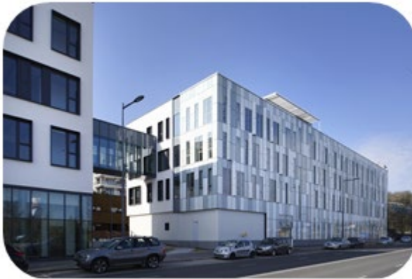
MEUDON - GREEN OFFICE ® EN SEINE (BUREAUX - 5 400 M 2 )
