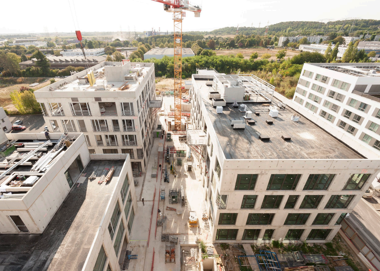
En couverture, perspective du campus de Massy © Simonetti-Malaspina & Associés et sur cette page, photo du chantier du campus de Massy lancé en octobre 2017 avec une livraison prévue en mai 2019© G. MAIMONE
