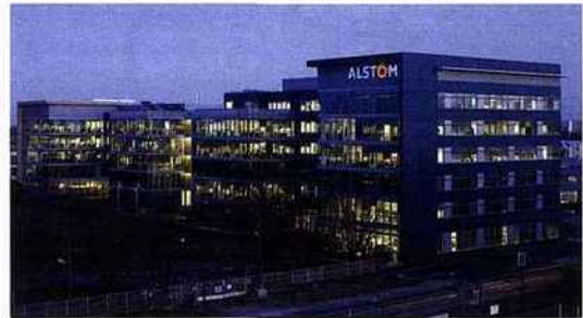
Immeuble rue Jean Bart à Massy (91), développant 16 400 m 2
