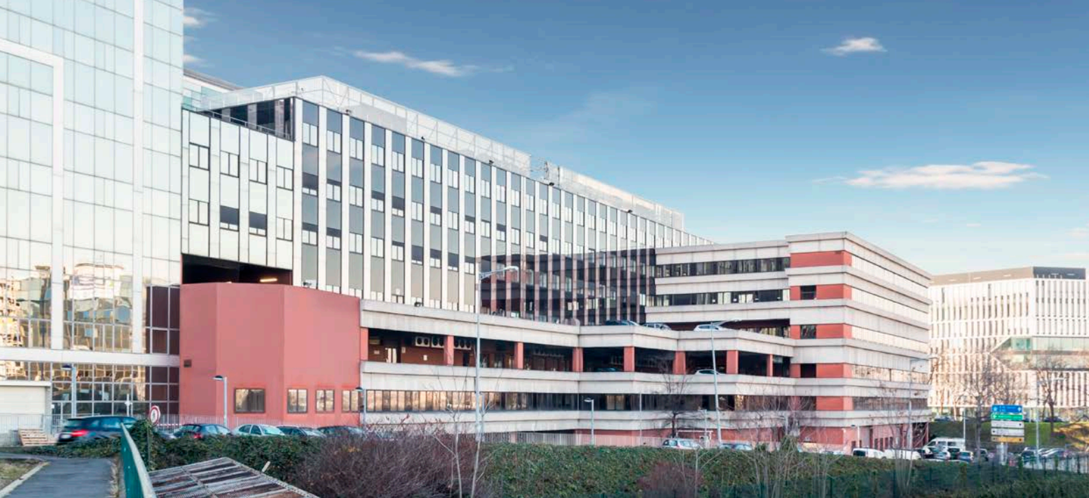
En couverture et sur cette page, Défense 3 rebaptisé Delta – Nanterre - acquis en 2016 © Manuel PANAGET
